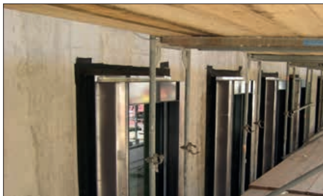
Anwendungsbeispiel für Fasatan® Optima bei vorgesetzten Fensterelementen.
